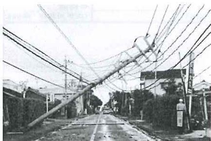
平成11年の台風18号による被害
